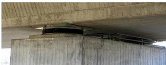
Modèle de capteur de compression unique au monde, qui repose sur un palier élastomère, et qui présente des avantages inégalés par rapport à tous les autres capteurs de compression du marché.
