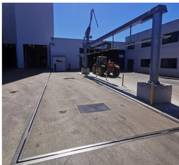
**Pont bascule DualBLOCK TOUT BÉTON spécialement conçu pour le pesage XXL.**
