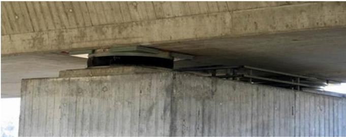
Modèle de capteur de compression unique au monde, qui repose sur un palier élastomère, et qui présente des avantages inégalés par rapport à tous les autres capteurs de compression du marché.
