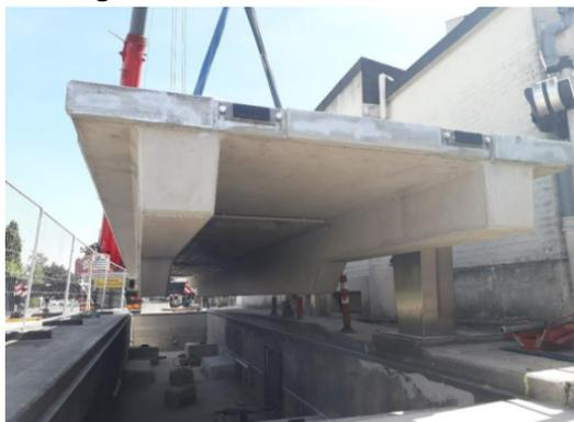
Vue de face du pont bascule béton MonoBLOCK
